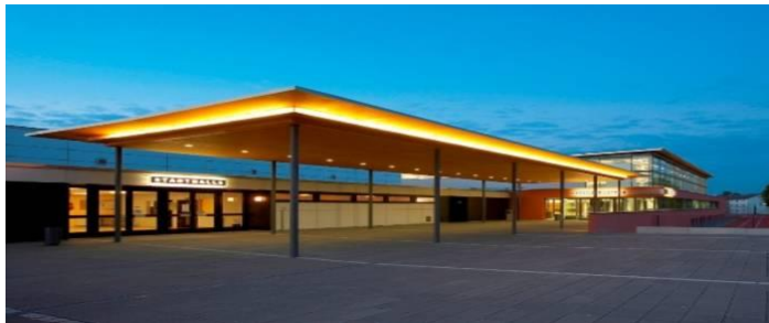
Stadthalle Eppingen, Foto: www.google.de
