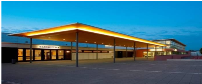
Stadthalle Eppingen, Foto: www.google.de
